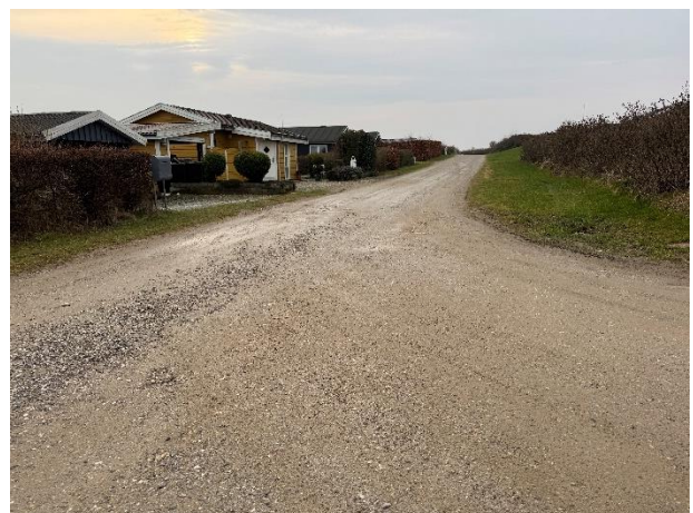
Figur 44. Optrængende fugt på Belisvej efter flere dage med tørvejr
