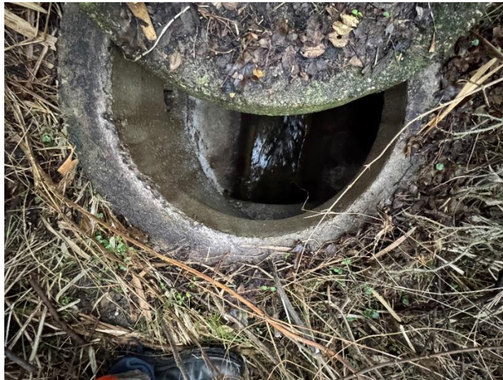
Figur 26. Brønden ved strandkanten
