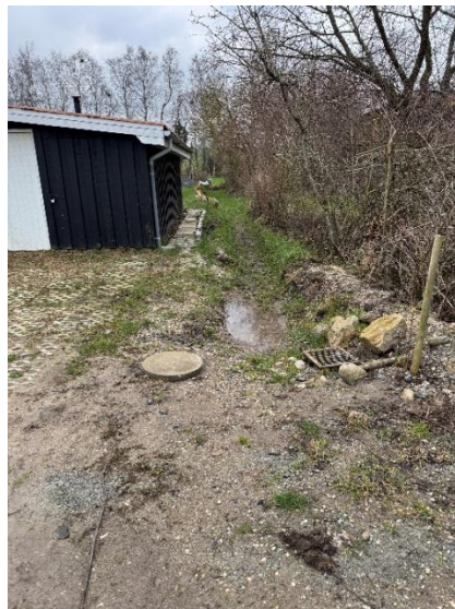
Figur 16. Grøft ved Følfodvej 6
