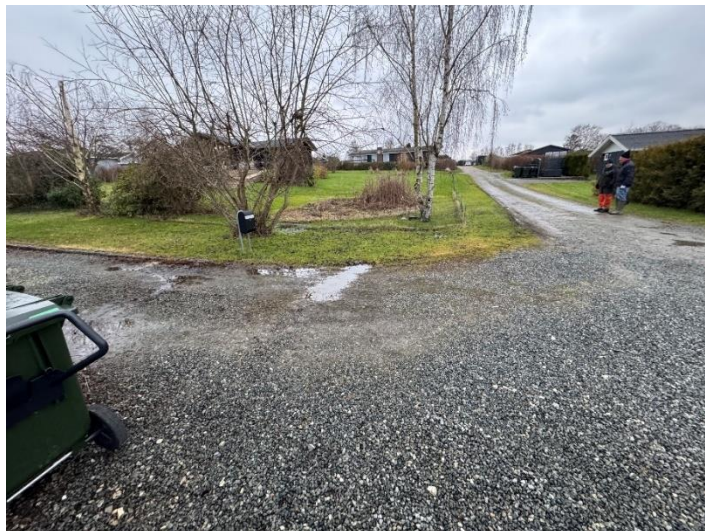
Figur 19. Fugtigt område ved Ranunkelvej 9
