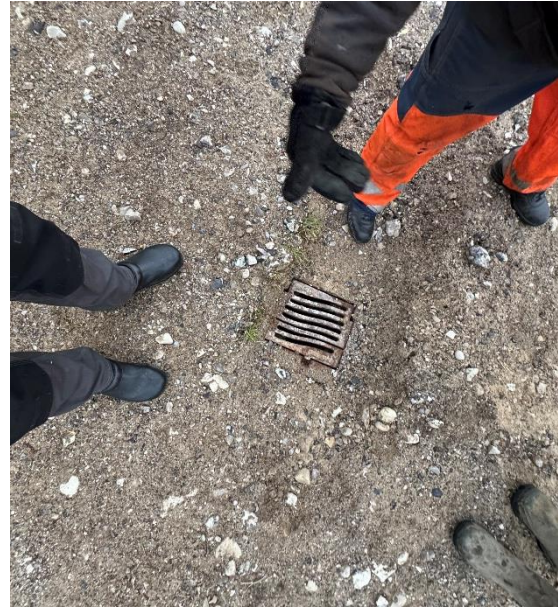
Figur 31. Afløb i Røllikevej
