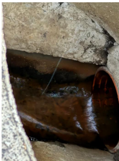
Figur 20. Brønden ved Toftegårdsvej 22
