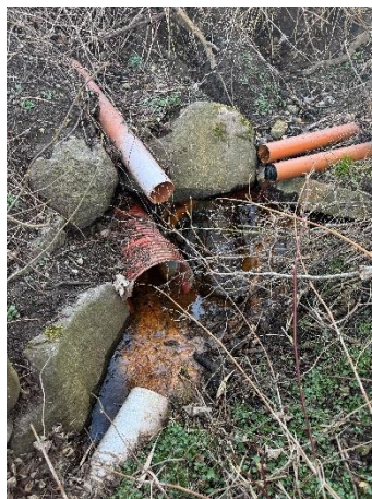
Figur 6. Underføring ved Aarhusvej
