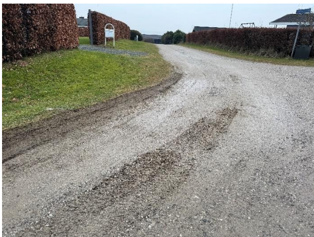
Figur 44. Optrængende fugt på Belisvej efter flere dage med tørvejr
