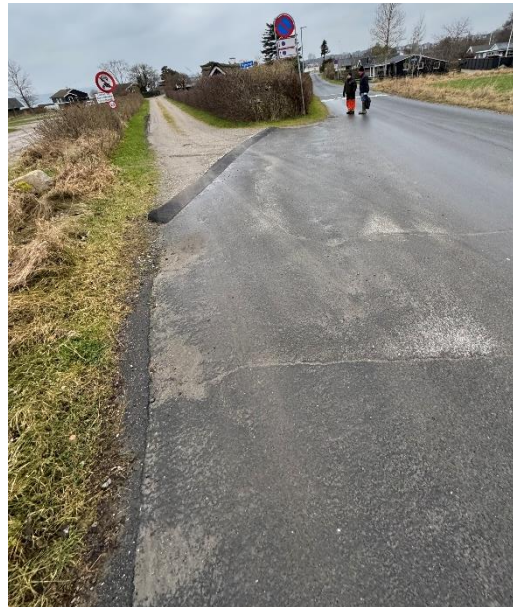
Figur 35. Indkørsel til Hybenvej
