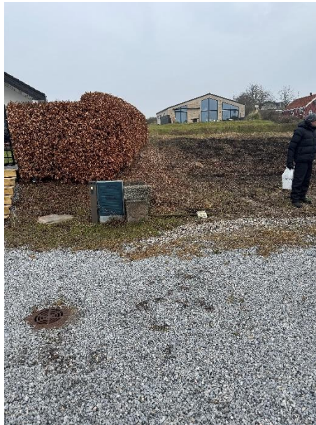
Figur 43. Dræn langs hækken ved Søren Møllersvej 16/18 tilsluttet brønd i vej
